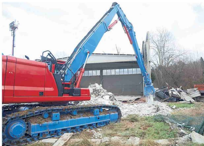
▲ Ruspe al lavoro per un intervento legato ai fondi del Pnrr
