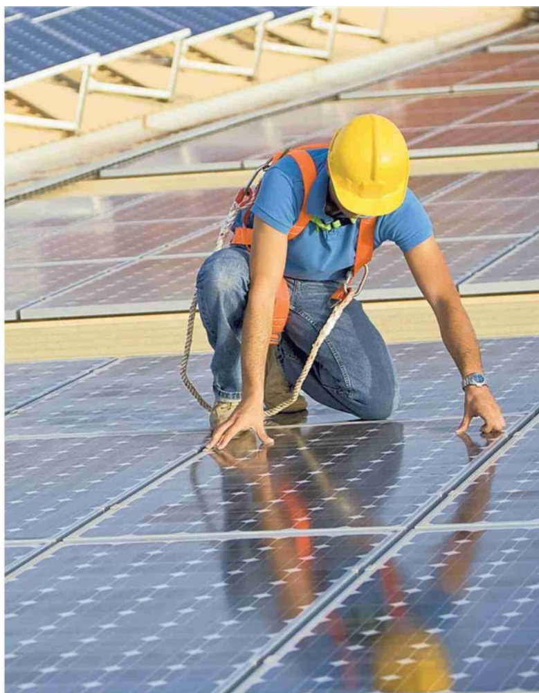
▲ Pannelli sui tetti Dal sole energia alternativa per la città del futuro
