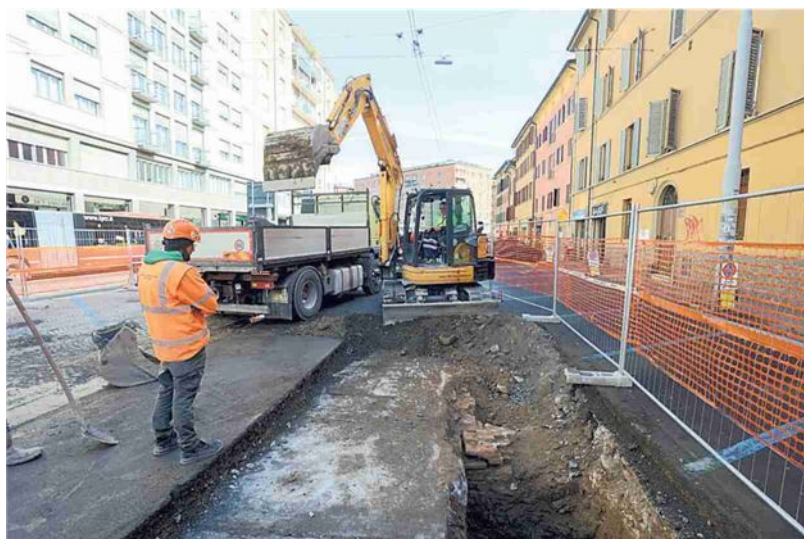
▲ Il cantiere I lavori in via Riva Reno propedeutici al passaggio del tram
