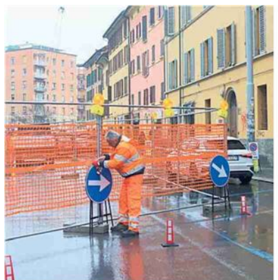
▲ Il cantiere in via Riva Reno
